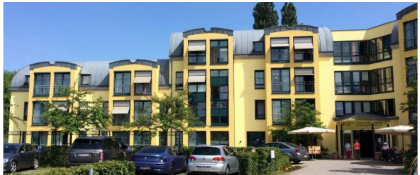
Das DRK Darmstadt denkt bei der Sanierung dieses Pflegeheims auch über Wohnungen für die Beschäftigten nach
