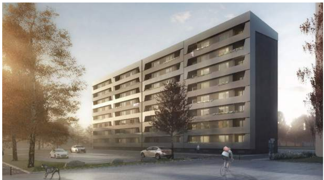
Quartiersaufwertung im Bestand: Die Planung sieht die Sanierung von 64 Wohnungen bis 2018 vor
